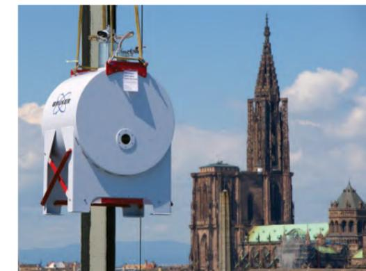
Pesant environ deux tonnes, c'est par le toit de l'IBMP que Solarix FTMS a été livré.
