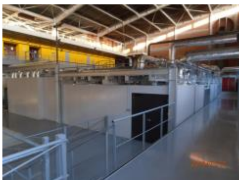
Vue extérieure des salles blanches
